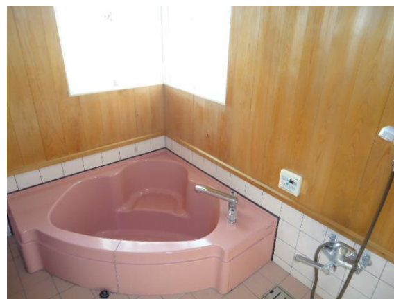
1階木壁の浴室
