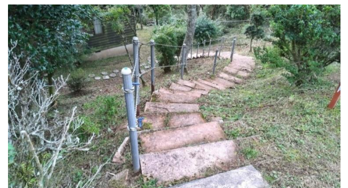
道路から玄関へ降りる階段と踏石
