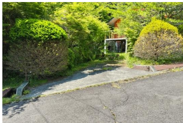
駐車場を兼ねた水路のコンクリート通行橋
