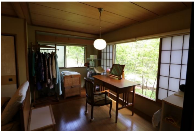
1 階東側の和室は床をフローリングに改装
