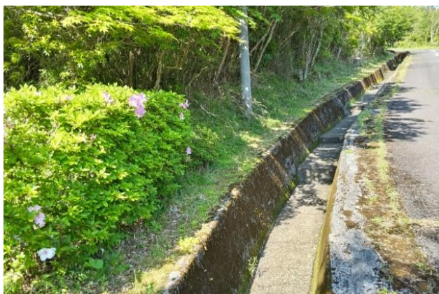
敷地前の水路は、雨天時のみ雨水が流れます
